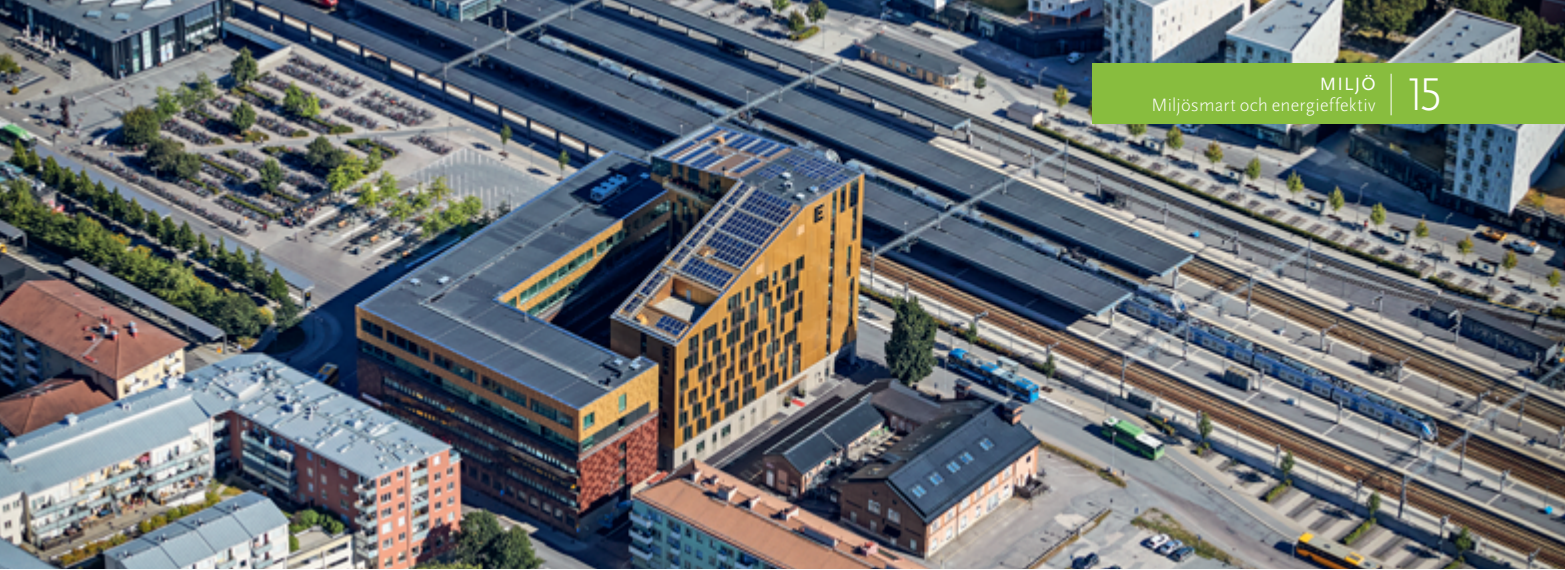
En av Klöverns solcellsanläggningar återfinns på fastigheten Kungsängen 10:2 i Uppsala.
